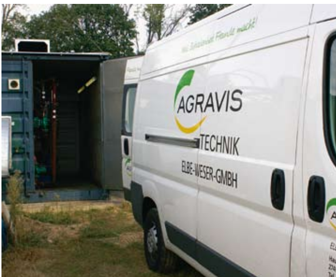
Regelmäßig muss die Biogasanlage gewartet werden und auch im Notfall ist die AGRAVIS Technik Elbe-Weser GmbH schnell vor Ort, um Standzeiten der Anlage gering zu halten.
